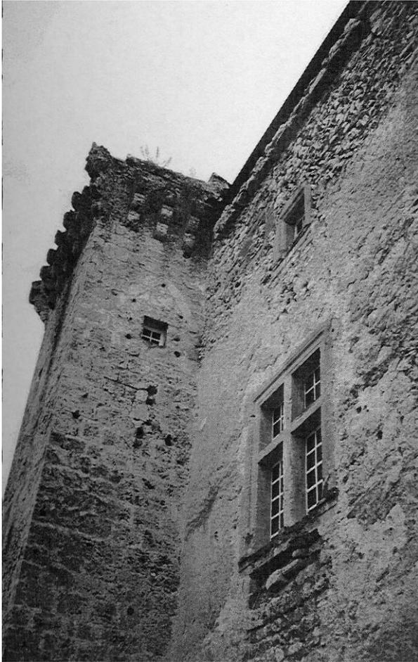
Il s'agit du mur de la façade Nord/Ouest flanqué d'une tour en tuf, bien appareillé. L'ensemble est couronné de mâchicoulis dont il ne reste que les consoles à trois assises de tuf. Elles supportaient un ancien chemin de ronde dont on retrouve aussi les angles arrondis. S'agissait-il ici de la base de tours d'observation ?
